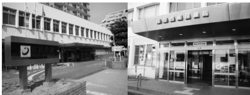
図3.1. (左) 東区役所 (右) 東保健所 (東区保健福祉センター) 東区HPより
